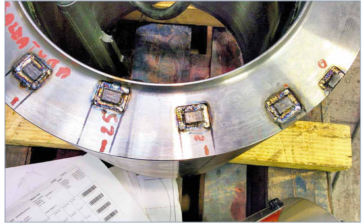
Realizzazione difetti sub superficiali con chiusura tramite saldatura TIG prima della saldatura finale.
